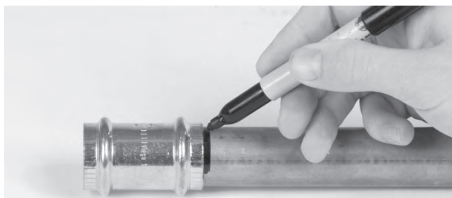
Figura 8 – Marque el tubo aún después de haberlo insertado hasta el resalte del acoplamiento
