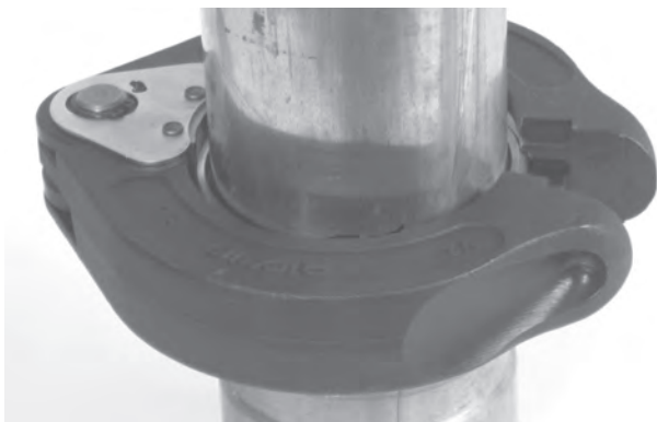
Figure 12A – Installation d'une bague ProPress XL-C sur le raccord
