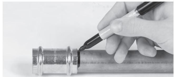
Figure 8 – Repérage du tuyau après insertion complète
