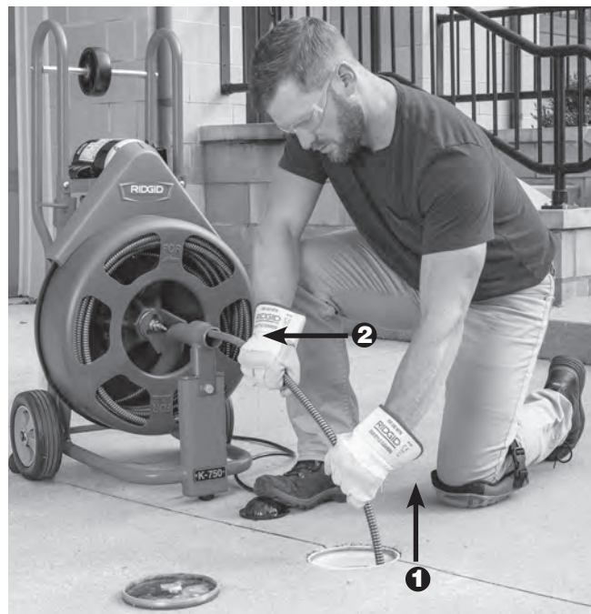
Figura 14 – El operario está (1) jalando el cable y (2) metiéndolo en el tambor
