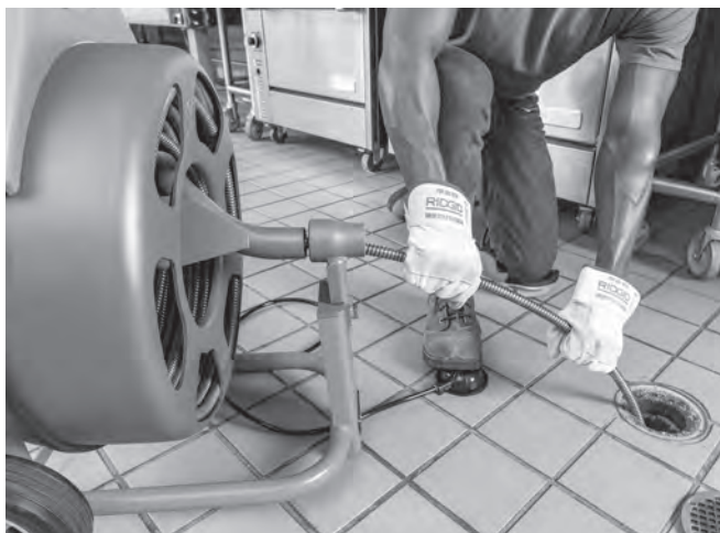
Figura 13 – Introducción del cable en el desagüe
