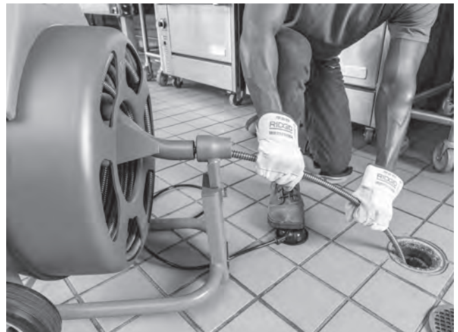
Figure 13 – Avancement du câble
