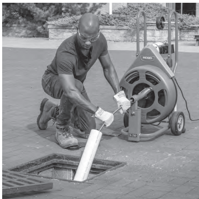
Figure 7 – Exemple de prolongation de l'évacuation pour l'amener à moins de 3 pieds de la sortie de câble
