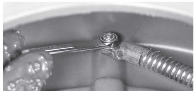
Figura 30 – Perno de anclaje del acoplamiento flexible pigtail
