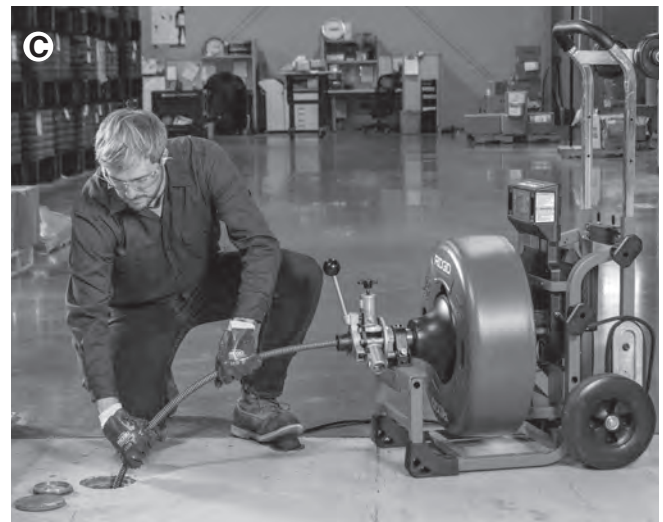
Figure 20A,B,C – Avancement manuel du câble
