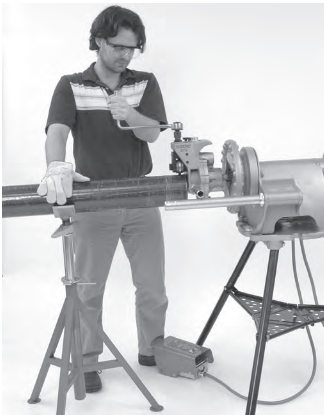
Figura 13 – Aplicación de fuerza al tubo durante el ranurado, para mejorar la trayectoria de la ranura
