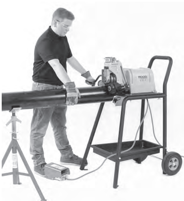
Figura 17 – Aplicación de presión sobre el tubo
