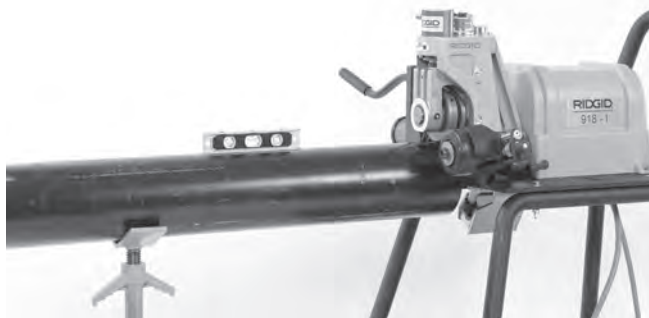
Figure 12 – Nivellement du tuyau
