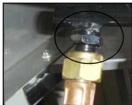
Verificación para la detección de fugas en la conexión de gas
