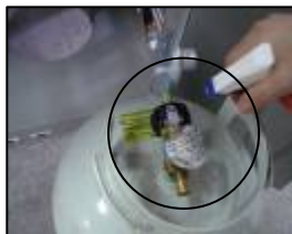
Verificación para la detección de fugas en la conexión de gas
