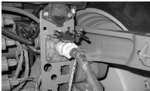
Връзка на кабелния сноп на CAN
