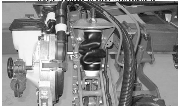
Muelle neumático enrollado en forma incorrecta (hilera doble)
