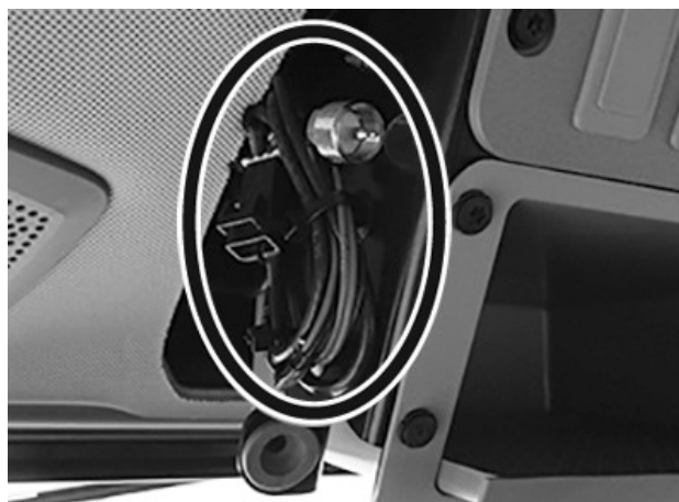
天线和电源电缆
