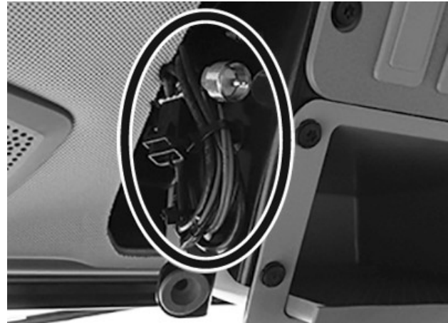
Antenn ja toitekaablid
