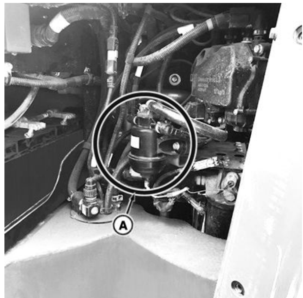
Filtrul DEF în linie (A) se află în interiorul compartimentului bateriei.
