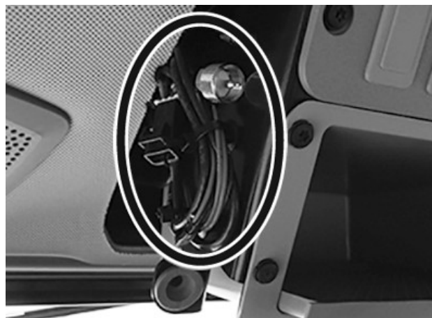
Antenn och strömkablar
