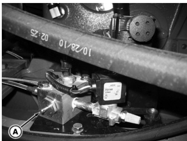
Õhutusklaapp vedrustusega silla kohal
