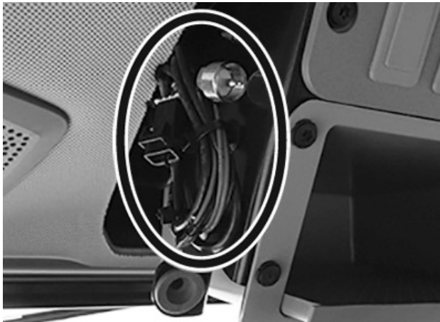
Przewody antenowe i zasilania
