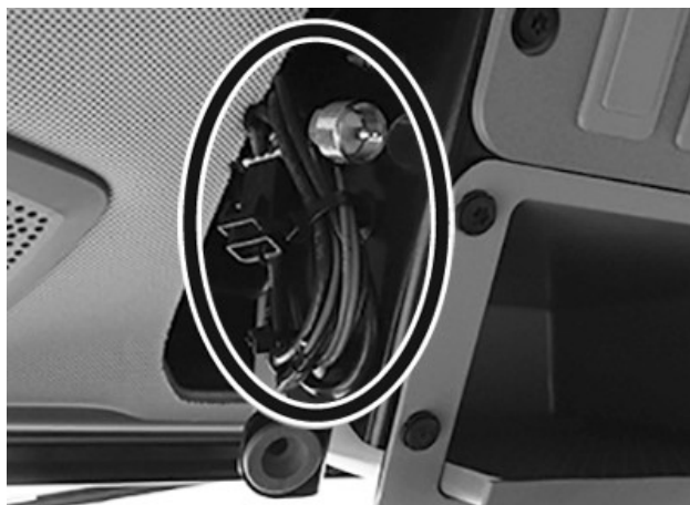
Antena y cables de alimentación
