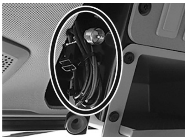
Antenne og strømkabler
