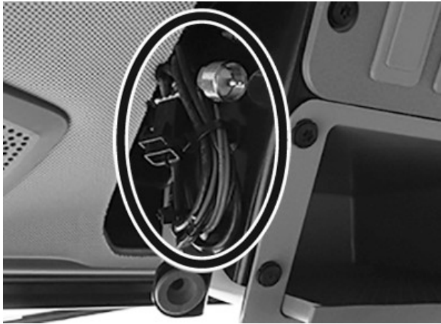
Antenn och strömkablar
