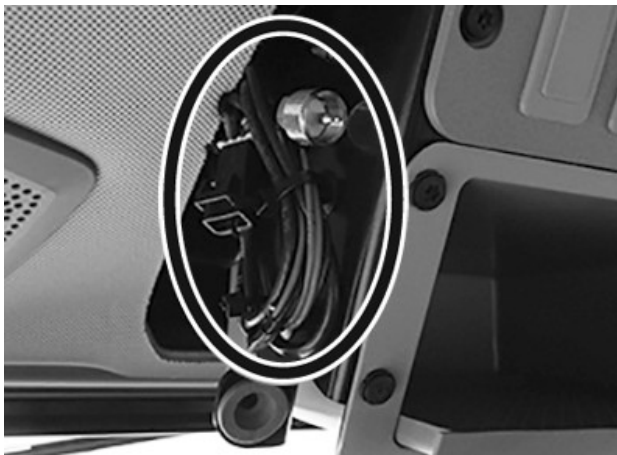
Antena y cables de alimentación
