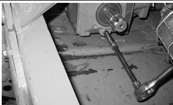
Retiro del tapón de vaciado
