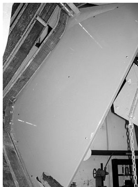
Painel de Desgaste da Estrutura da Tapa Mostrado
