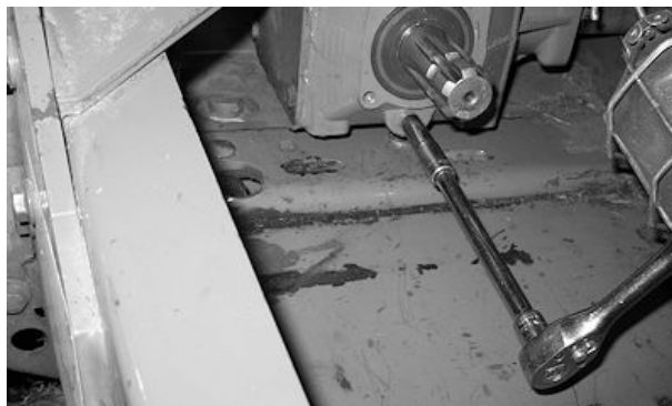
Retiro del tapón de vaciado
